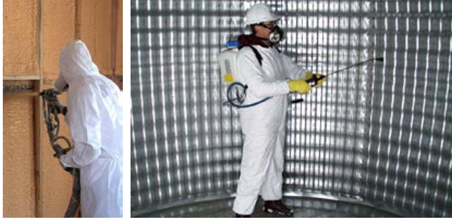
Şekil 6.6. Çatlak ve yarık uygulaması
